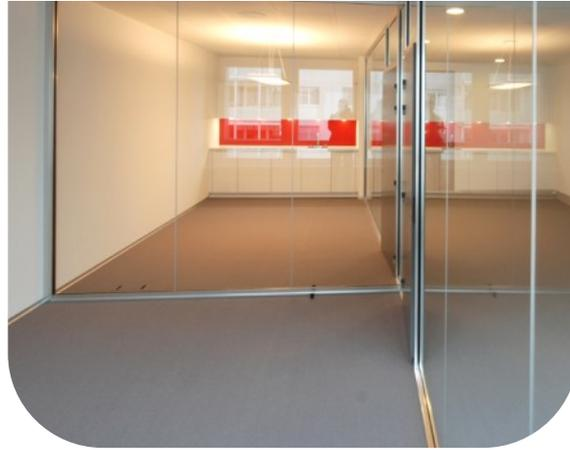
Auf die ganze Höhe verglast mit I-Verbindungsprofile aus Aluminium und ohne Ständer zwischen den einzelnen Verglasungen.
