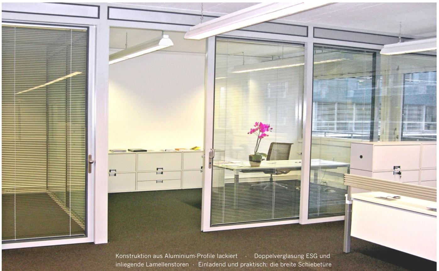
Konstruktion aus Aluminium-Profilen lackiert · Doppelverglasung ESG und inliegende Lamellenstoren · Einladend und praktisch: die breite Schiebetüre
