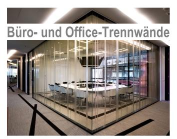
Eine neue Variante sind die Vollglas-Trennwände ohne Zwischenstützen. Stossverbindung der Gläser mittels integriertem Glasfugenprofil.
